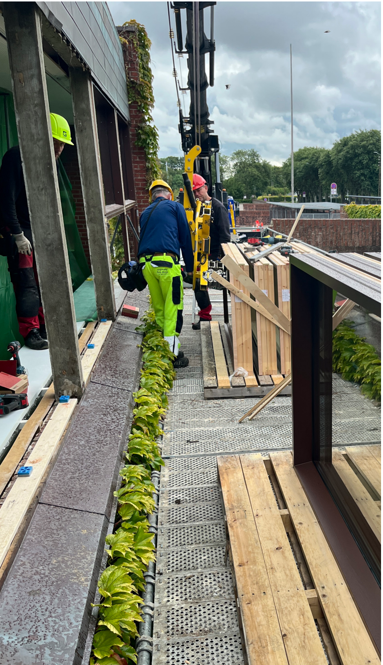
Omfattende energigrenovering af Solbakkeskolen i Aalborg med delvist specialtilpassede vinduer leveret af TL Vinduer
